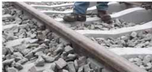
Reprofilierung mit Schotterpflug auf einer Seite ohne Schotterbesen
