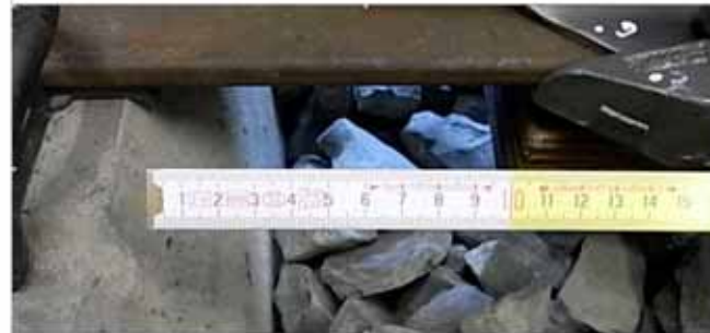
Abb.: Einbauraum für Bahnerdungsvorrichtung und "Feste Absperrung".
