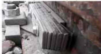
Verschmutzter Absorber nach Reprofilierung mit Schotterpflug: Keine Beschädigung!
