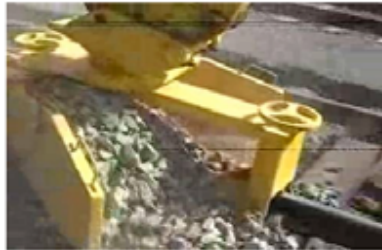
Reprofilierung mit Schotterpflug
