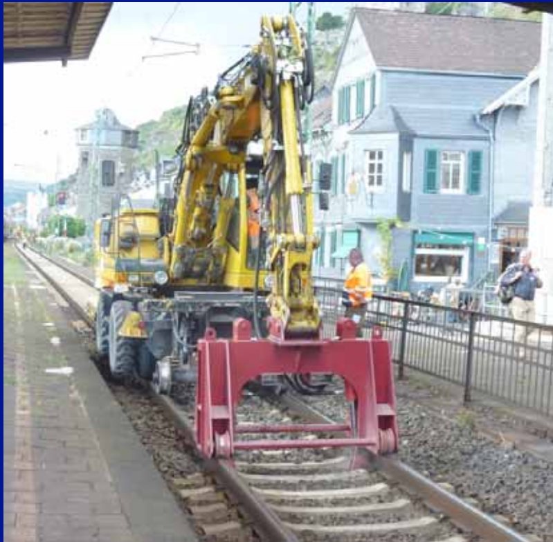
Vorbereitung mit Schotterschieber
