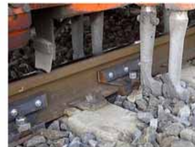
Abb.: Stopmaschine im Gleis mit Schienenabsorberrn
